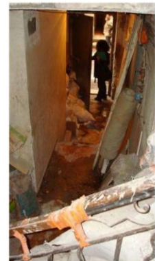
Cage d'escalier en cours de réhabilitation 21 rue Longue des Capucins
