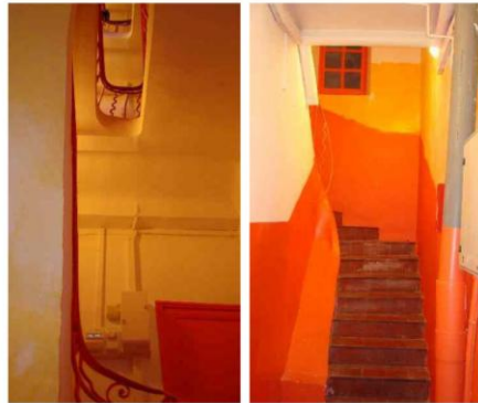
Cage d'escalier réhabilitée 2 rue de l'Académie
