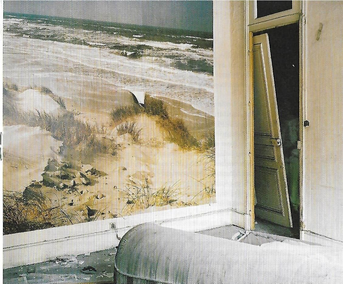
Appartement «dévitalisé» au 91 rue de la République (avril 2007). «Dévitalisé» : rendu inhabitable volontairement par le propriétaire, par destruction systématique des fenêtres, canalisations d'eau et de gaz, réseau électrique, salle de bain et toilettes.
